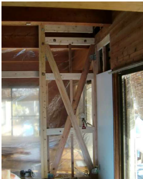
■ 筋かいを入れて補強する
