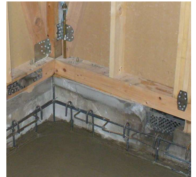
■ 基礎を補強する (施工中)
